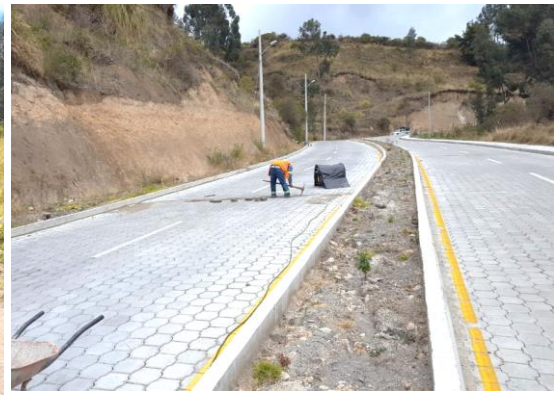
Vía de Adoquín
