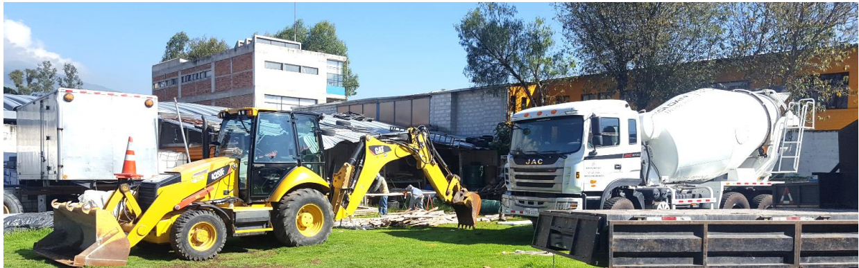
Equipo para Manejo de Agregados Petreos y Transporte de Hormigón
