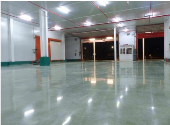
Piso de Hormigón Terminado Vitrificado
