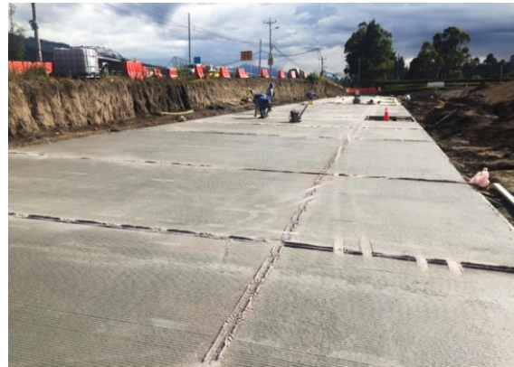
Corte de Juntas Vía de Hormigón
