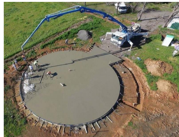
Cimentación para un Tanque de Gran Volumen
