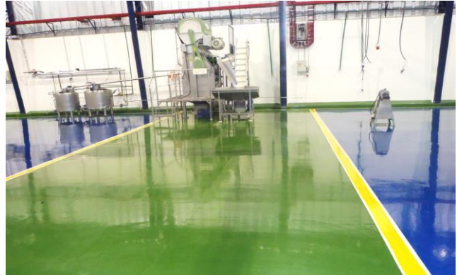
Piso Epóxico para un Taller de Mantenimiento Automotriz
