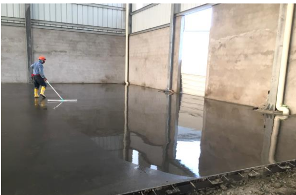
Piso de Hormigón Densificado
