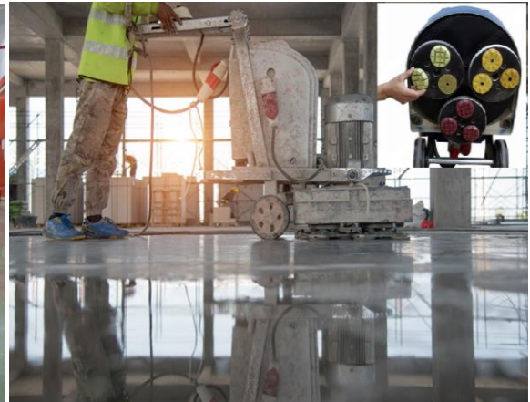
Pulido Diamantado de Hormigón
