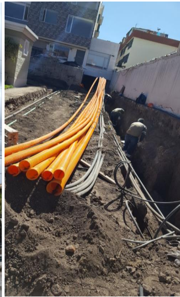
Construcción de Redes Eléctricas y de Comunicaciones Soterradas
