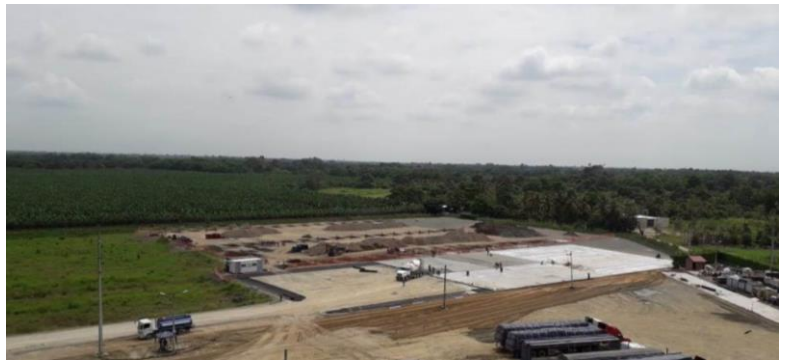
Nave Industrial en Construcción
