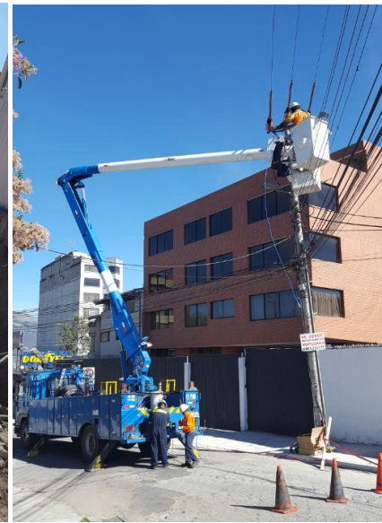
Trabajos Eléctricos en Medio Voltaje con Grupos de Líneas Energizadas
