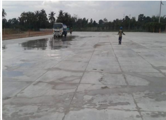
Piso TCP Terminado
