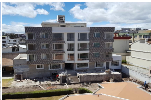
Edificio Fátima - 2019 (14 departamentos de 1, 2 y 3 dormitorios)
