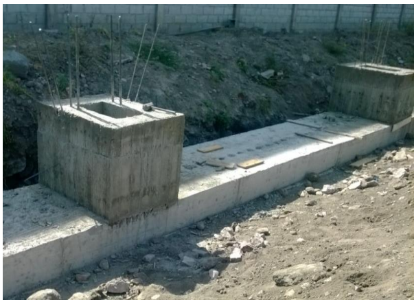
Cimentación Especial para una Nave Industrial
