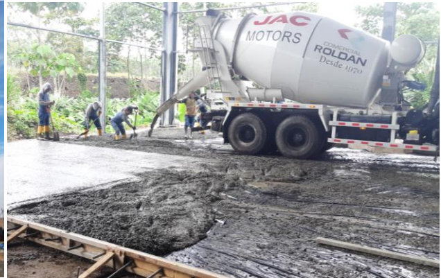
Instalación de Hormigón Producido en Obra
