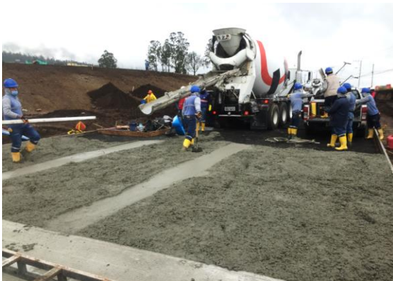
Fundición Vía de Hormigón
