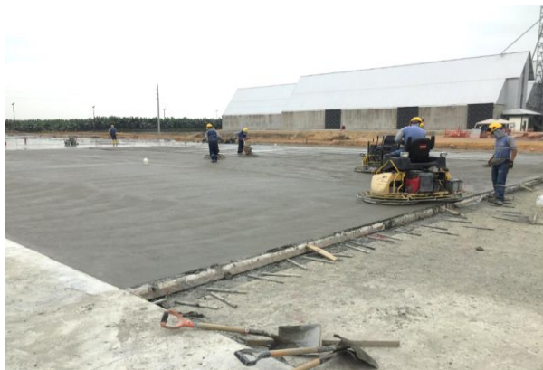
Construcción Patio de Maniobras
