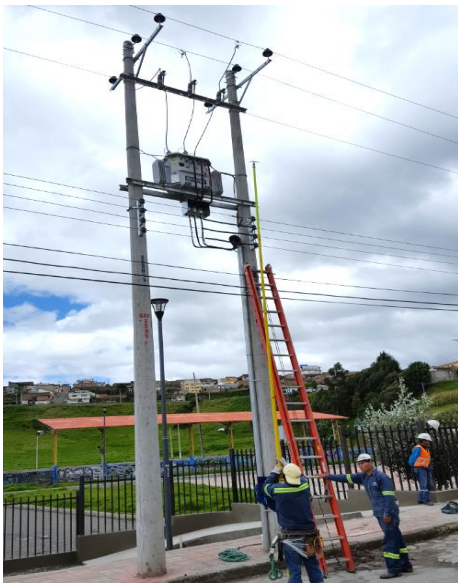
Construcción e Instalación de una Torres de Transformación
