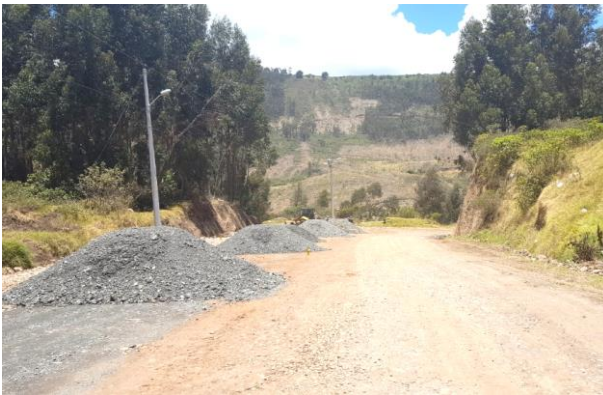
Preparación de la Rasante con Base Granular
