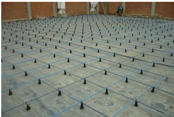
Estructura de un Piso Postensado
