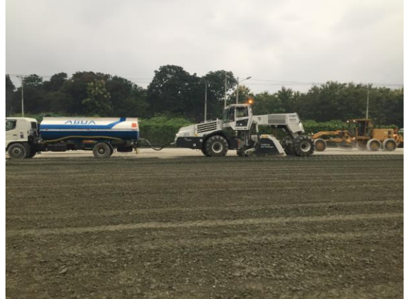
Instalación Base Granular Estabilizada con Cemento
