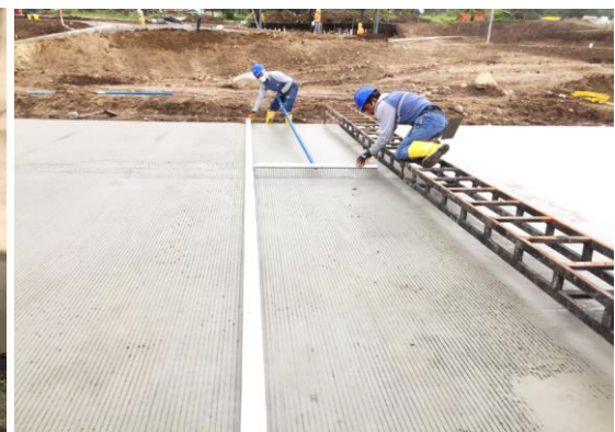
Terminado de Piso de Hormigón con Cepillo Texturizador
