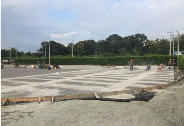
Corte de Juntas Piso Tipo TCP
