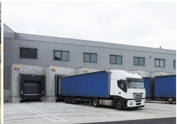
Patio de Maniobras en Operación
